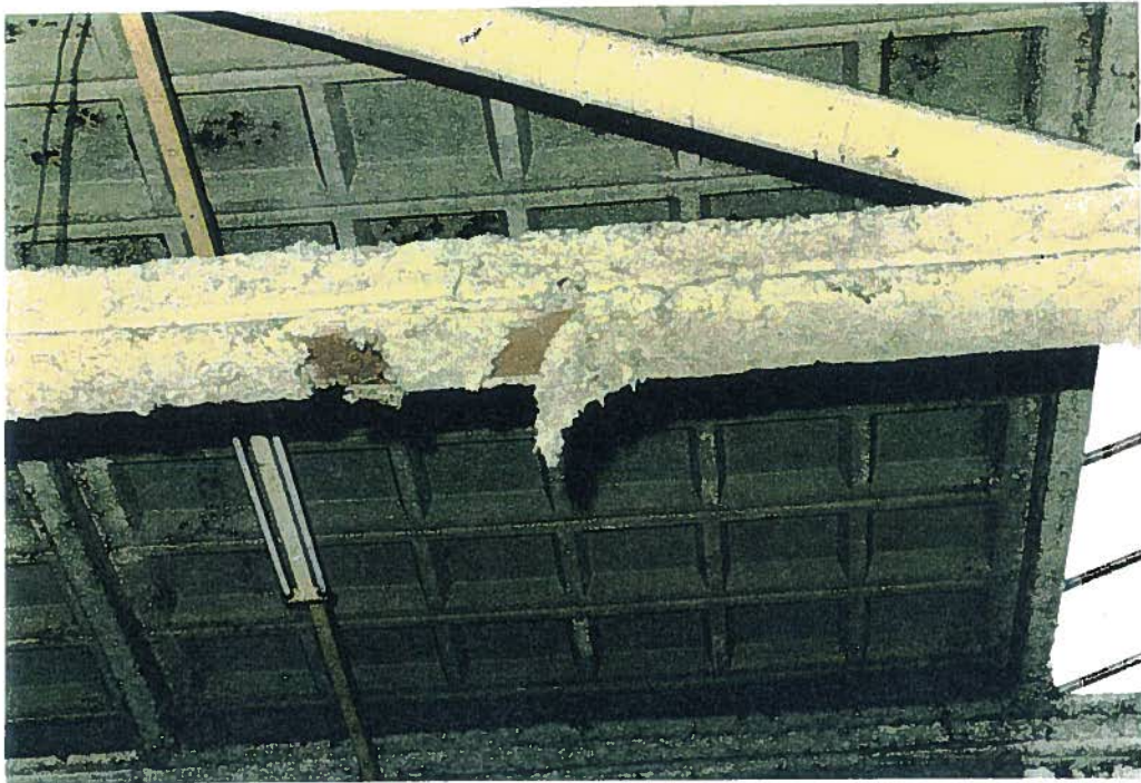
Figuur 1, asbestspuitlaag, foto J. Tempelman, TNO-MEP
